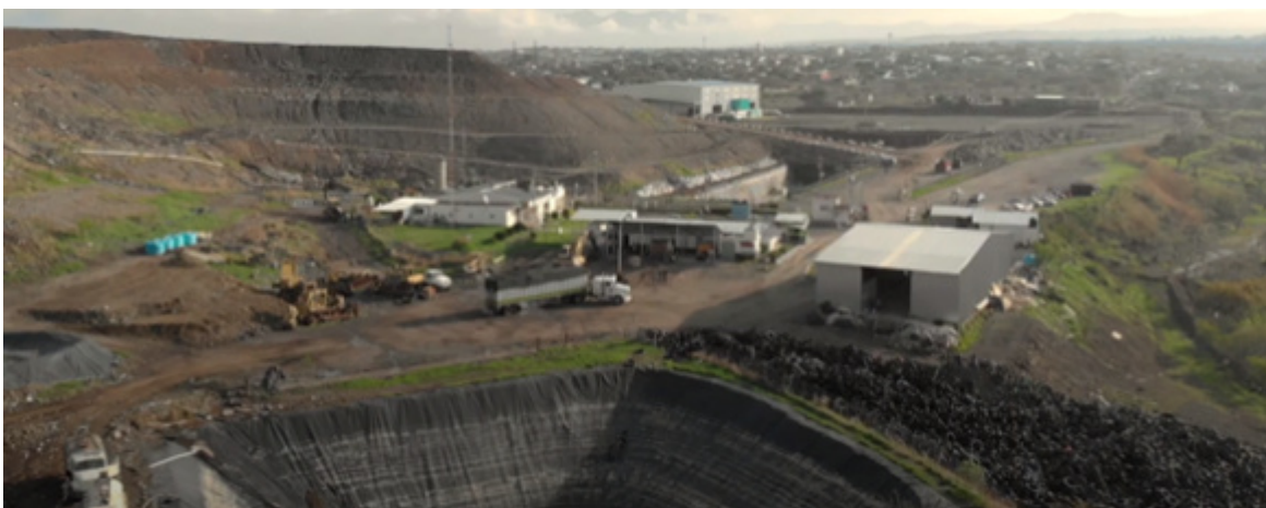
Relleno sanitario La Perseverancia
